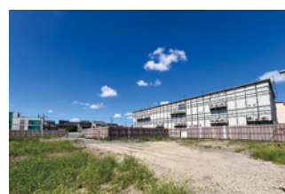
▲既存校舎解体工事終了後の様子
